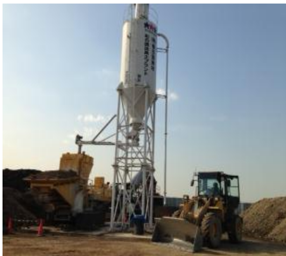
建設発生土受け入れ(改良土プラント)埼玉県春日部市下大増新田
